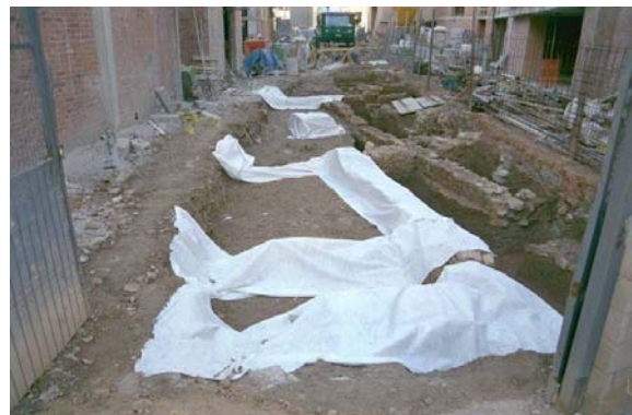
Cobriment de les restes no afectades amb geotextil
