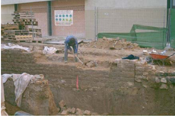
Desmuntatge de les estructures de forma manual.
